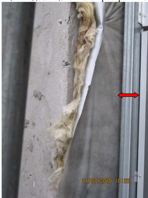
Фото 10. Величина воздушного зазора составляет 15-40мм вместо требуемых 50-100мм.
