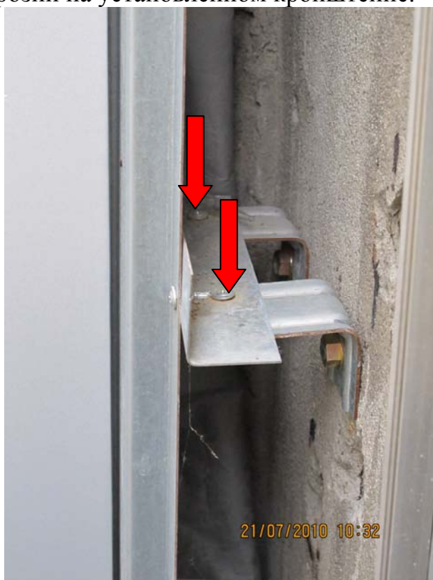
Фото 4. Крепление направляющей к кронштейну в одной точке.
