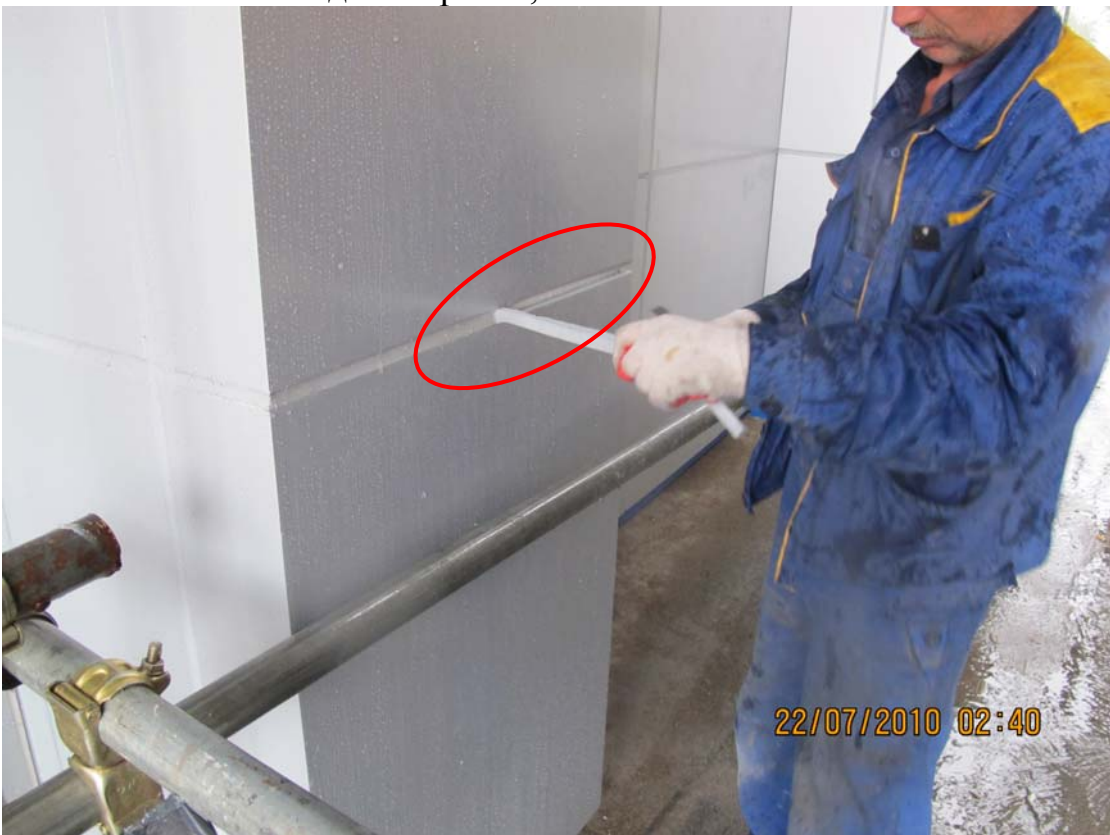
Фото 8. Все стыки между смонтированными панелями заполнены при помощи материала похожего на вилатерм, с последующей герметизацией.
