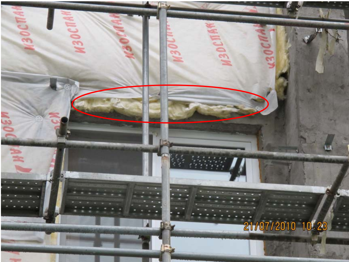
Фото 17. В качестве утеплителя применена минеральная вата из стеклянного штапельного волокна, плотностью 15-20 кг/м 3 .
