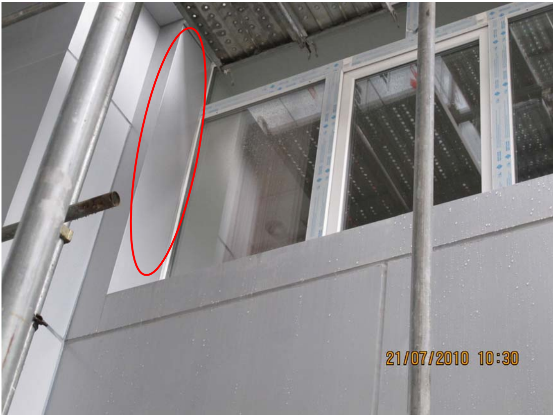
Фото 15. Оконные и дверные откосы (а так же другие участки стен – внутренние углы, пилястры, пояса и т.п.) выполнены из алюмокомпозитного материала, т.е. без устройства противопожарных коробов (рассечек).
