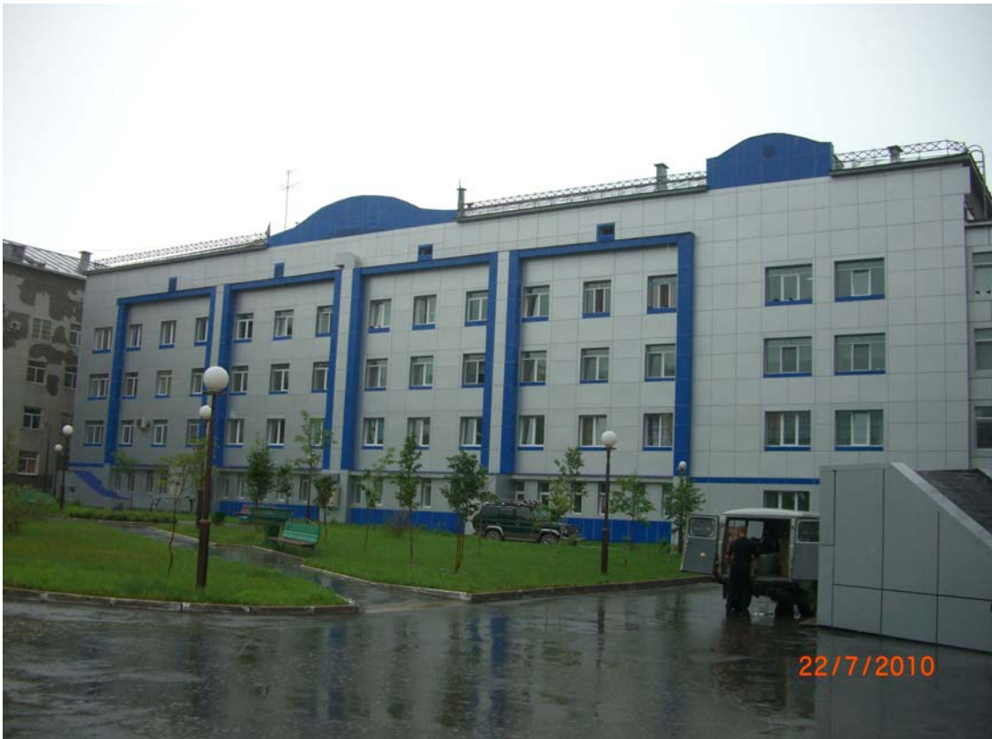
Фото 1. Общий вид корпуса с навесной фасадной системой с воздушным зазором.
