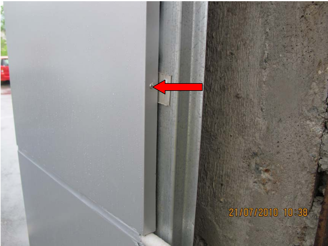
Фото 7. Для крепления кассет из композитного материала использованы вытяжные заклепки диаметром 4,0 мм.
