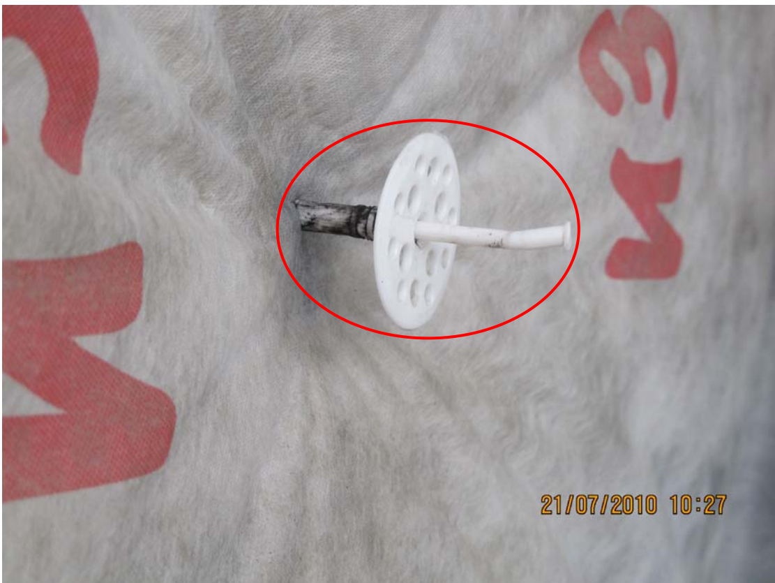
Фото 6. Дюбель крепления минераловатного утеплителя вынимается воздействием руки.
