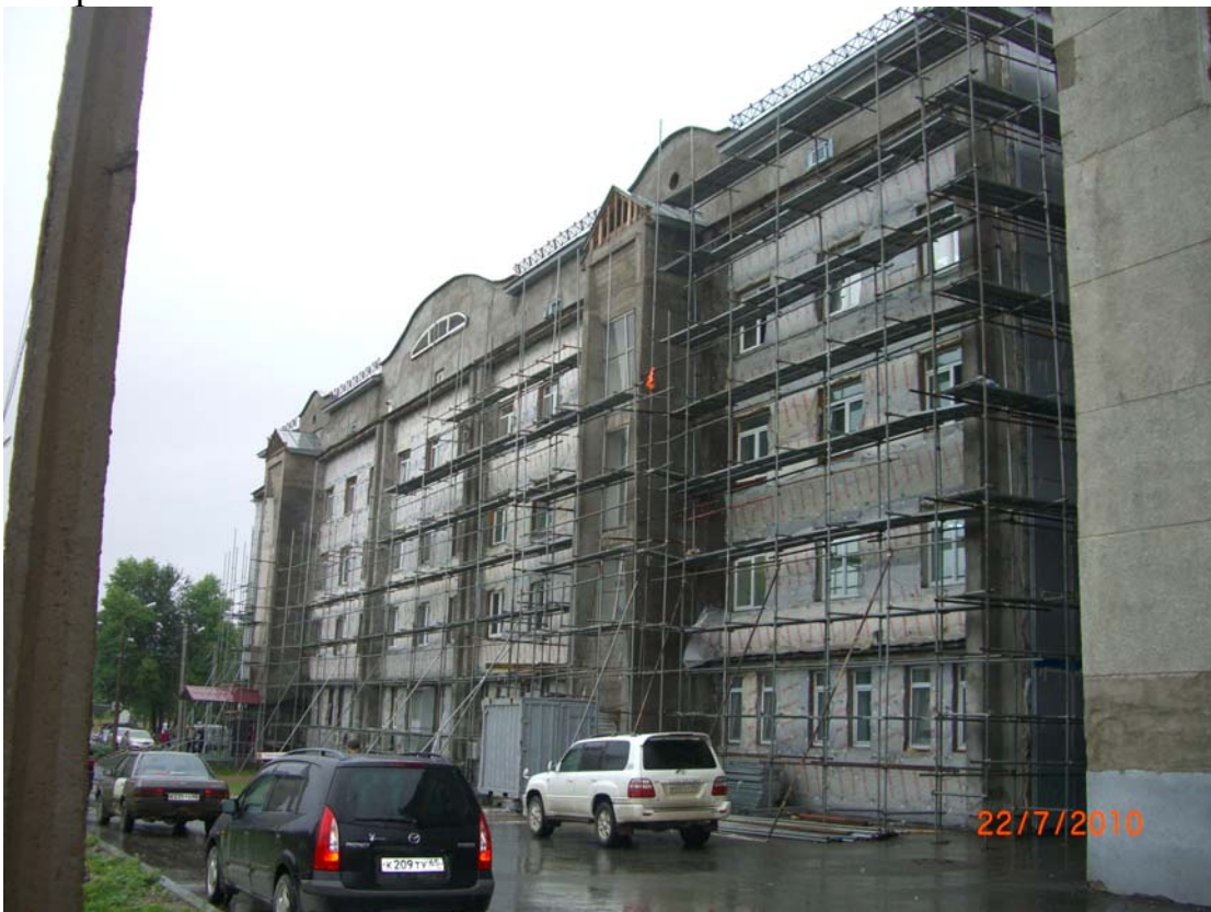
Фото 2. Общий вид корпуса в процессе монтажа.
