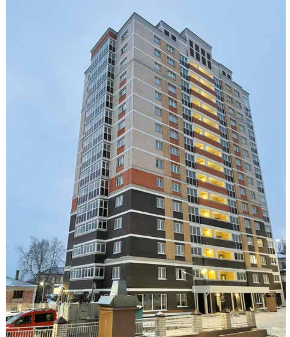
Жилой дом по ул. Газина ЖК «Аура»
