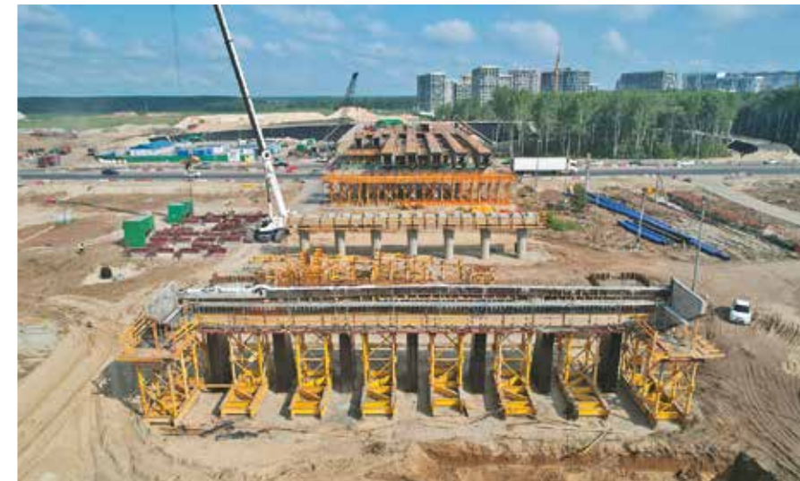
Строительство развязки на Московском тракте
